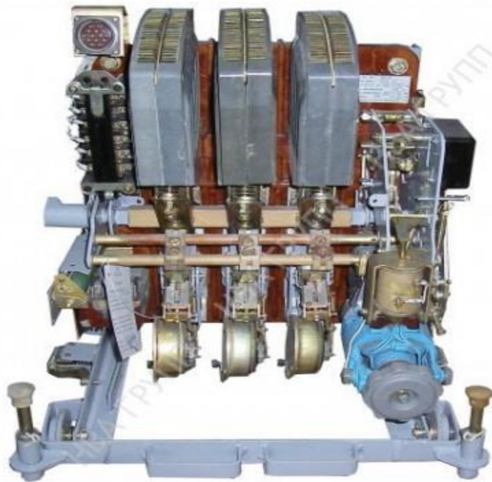
Рисунок 2.12 — Автоматический выключатель АВМ10Н на номинальный ток 1000А
