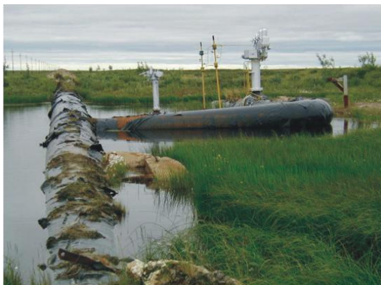
Рис. 1. Последствия, вызванные таянием многолетнемерзлых пород [6]
