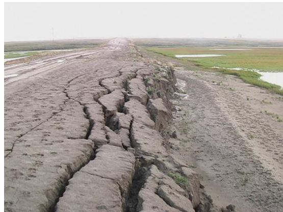
Рис. 1. Последствия, вызванные таянием многолетнемерзлых пород [6]
