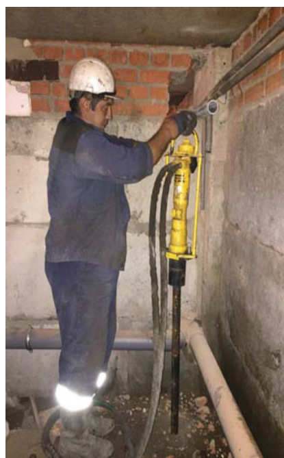
Рис. 7. Процесс нагнетания раствора под фундамент здания
