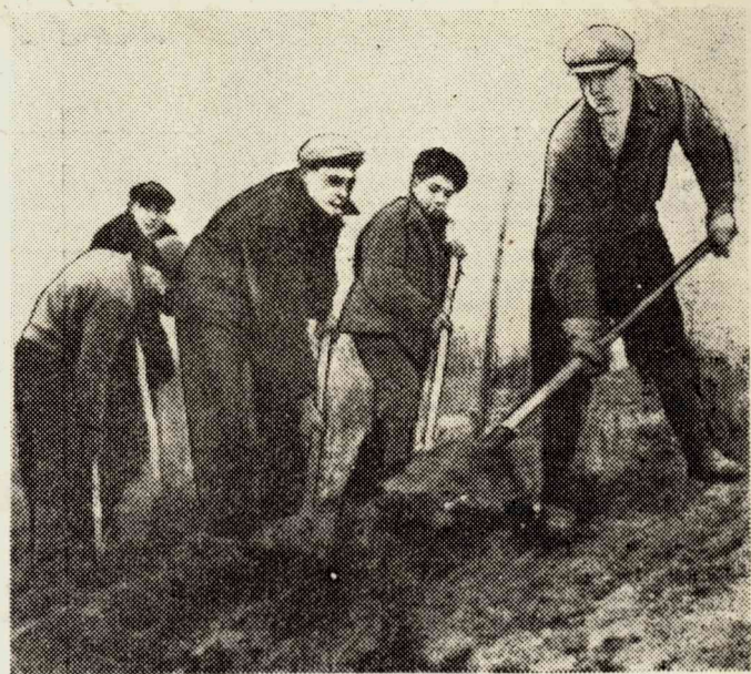
На постройке овощехранилища.
