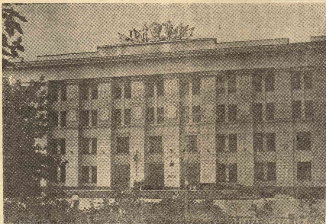
Новый учебный корпус ТПИ.
