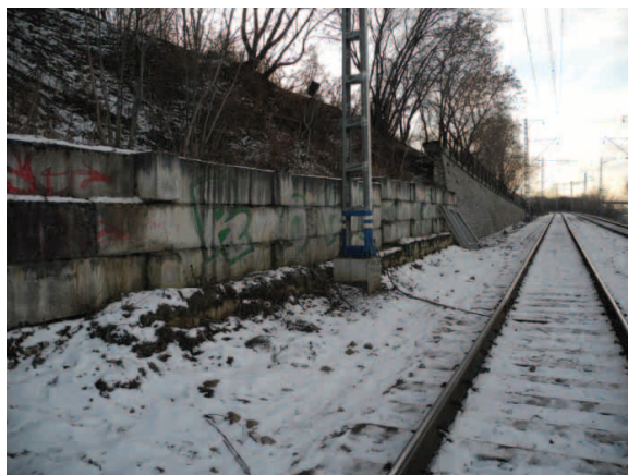
Рис. 2. Фрагмент правой части подпорной стенки, восстановленной после схода оползня
