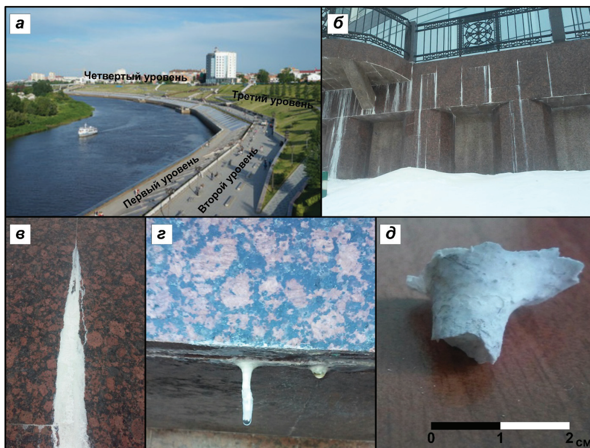
Рис. 1. а) общий вид набережной реки Туры; б) участок пробоотбора; в) карбонатная корка, развивающаяся по строительному шву, заполненному цементным раствором; г) натёчное образование в виде «соломинкообразного» тела; д) капле-видное натёчное образование
