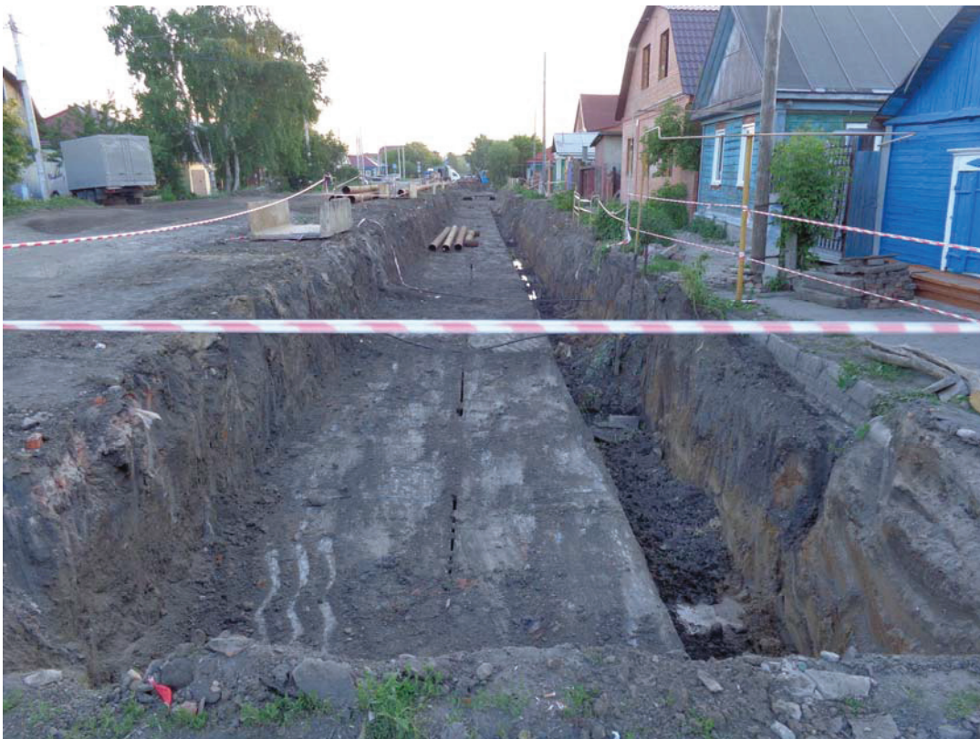
Рис. 1. Прокладка трубопровода через зону зеленых насаждений с плитой перекрытия, находящейся на глубине около полуметра ниже уровня земли
