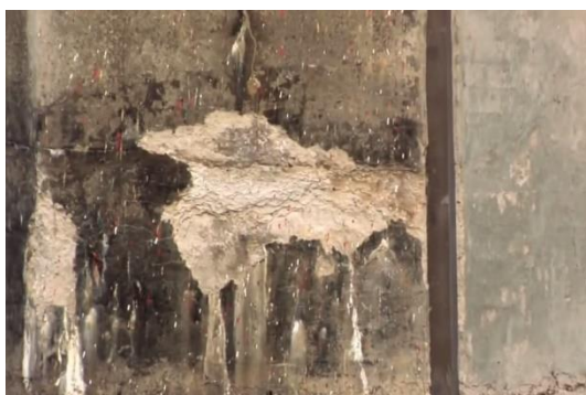
Рис. 1. Коррозия гидротехнического бетона
