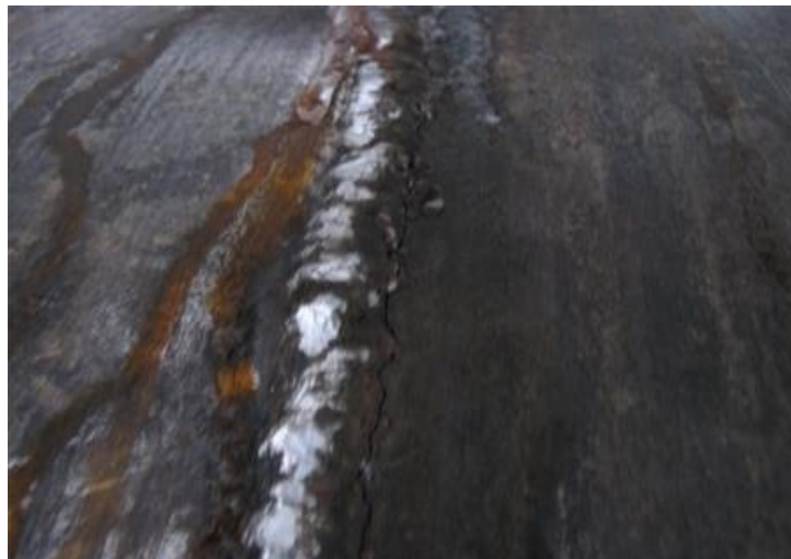
Рис.1 Трещина в околошовной зоне сварного соединения корпуса насоса
