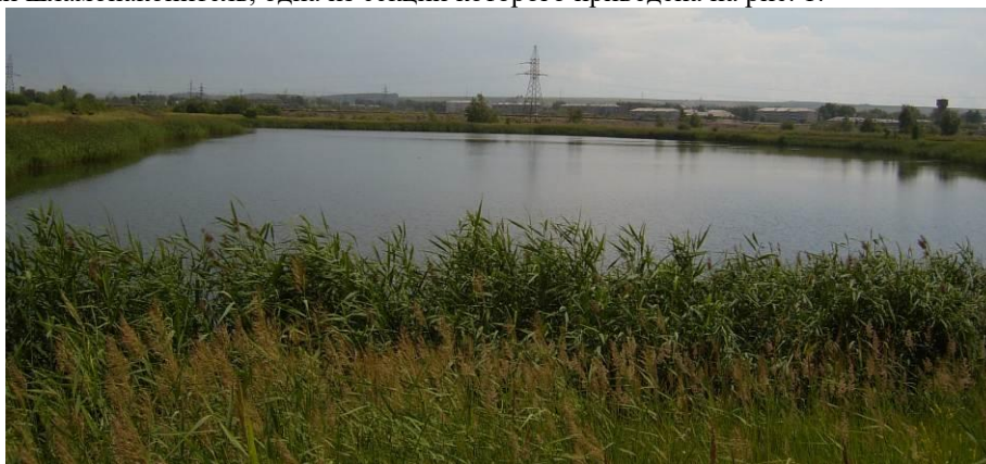
Рис. 1. Шламонакопитель цинксоодержащих шламов производства вискозного волокна (г. Красноярск)
