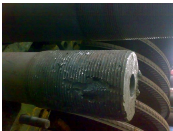
Рисунок П1.11 – Повреждения шпильки ЦВД
