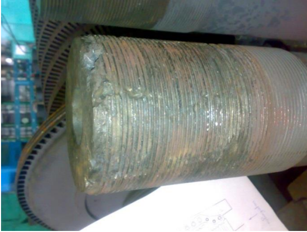
Рисунок П1.12 – Повреждения шпильки ЦВД
