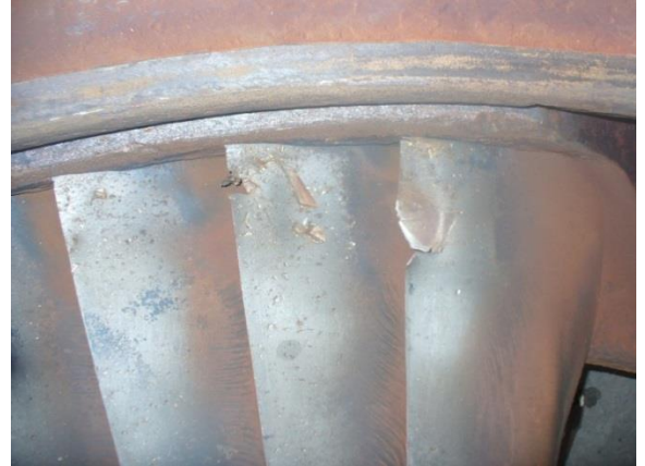
Рисунок П1.2 – Повреждения лопаток последней ступени
