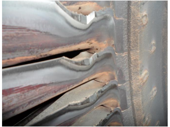
Рисунок П1.25 – Повреждения лопаток турбоустановки Т-100-130
