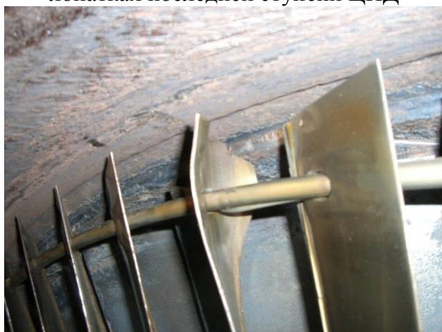
Рисунок П1.8 – Повреждения лопаток ротора низкого давления
