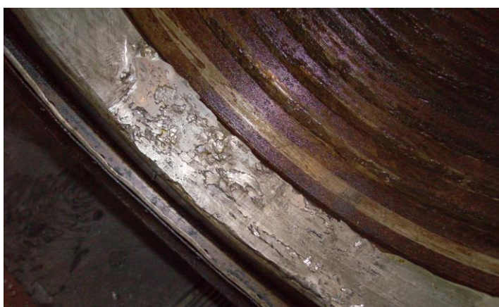
Рисунок П1.22 – Повреждения ротора
