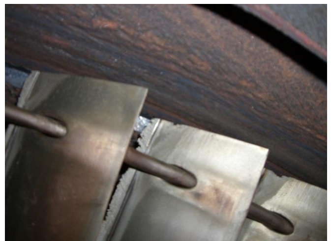
Рисунок П1.5 – Повреждения рабочих лопаток последней ступени ЦНД
