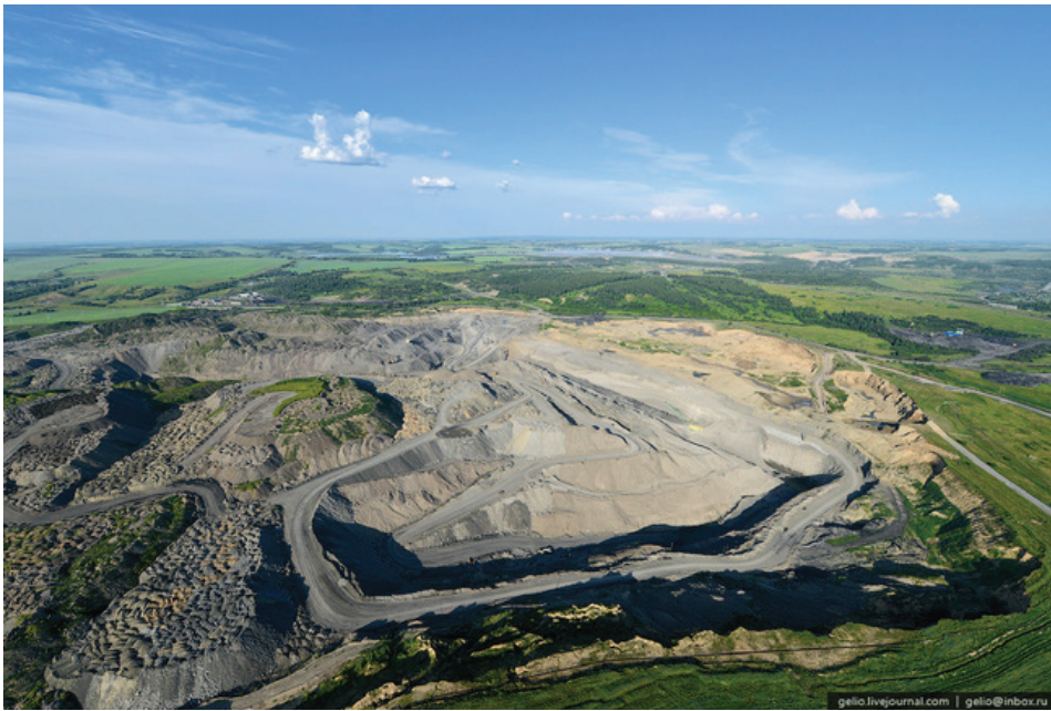
Рис. 3. Нарушенная поверхность рельефа над шахтой «Алексиевская» [14]
