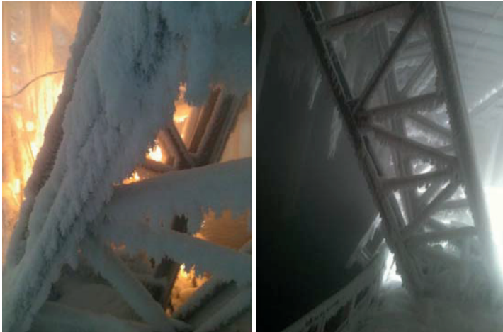
Рис. 12. Каркас градирни в зимний период
