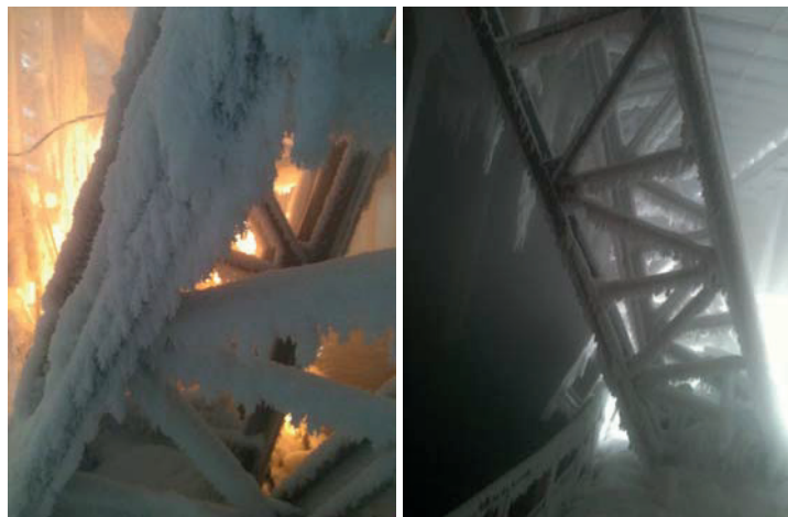
Рис. 12. Каркас градирни в зимний период
