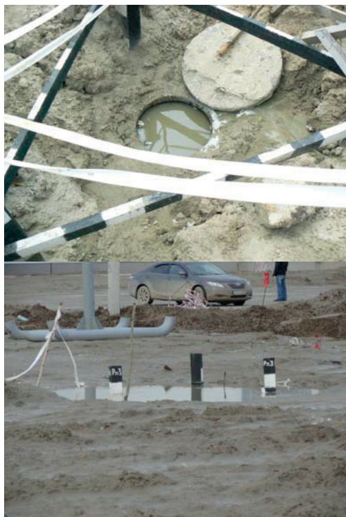
Рис. 2. Общий вид грунтового репера № 3
