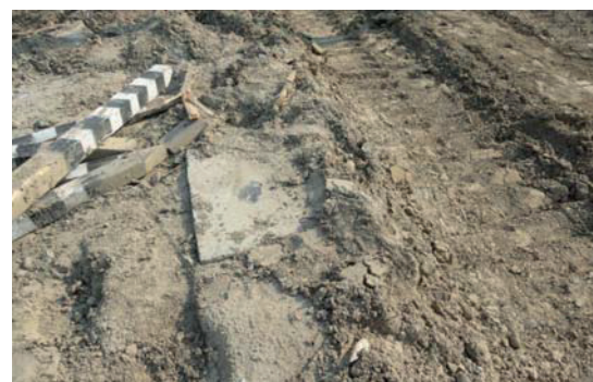
Рис. 3. Внешний вид ПСС после наезда гусеничной техники
