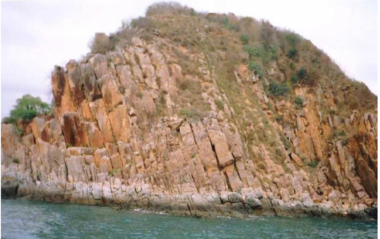
Рисунок 1.4 – Система трещиноватости на поверхности горной породы.
