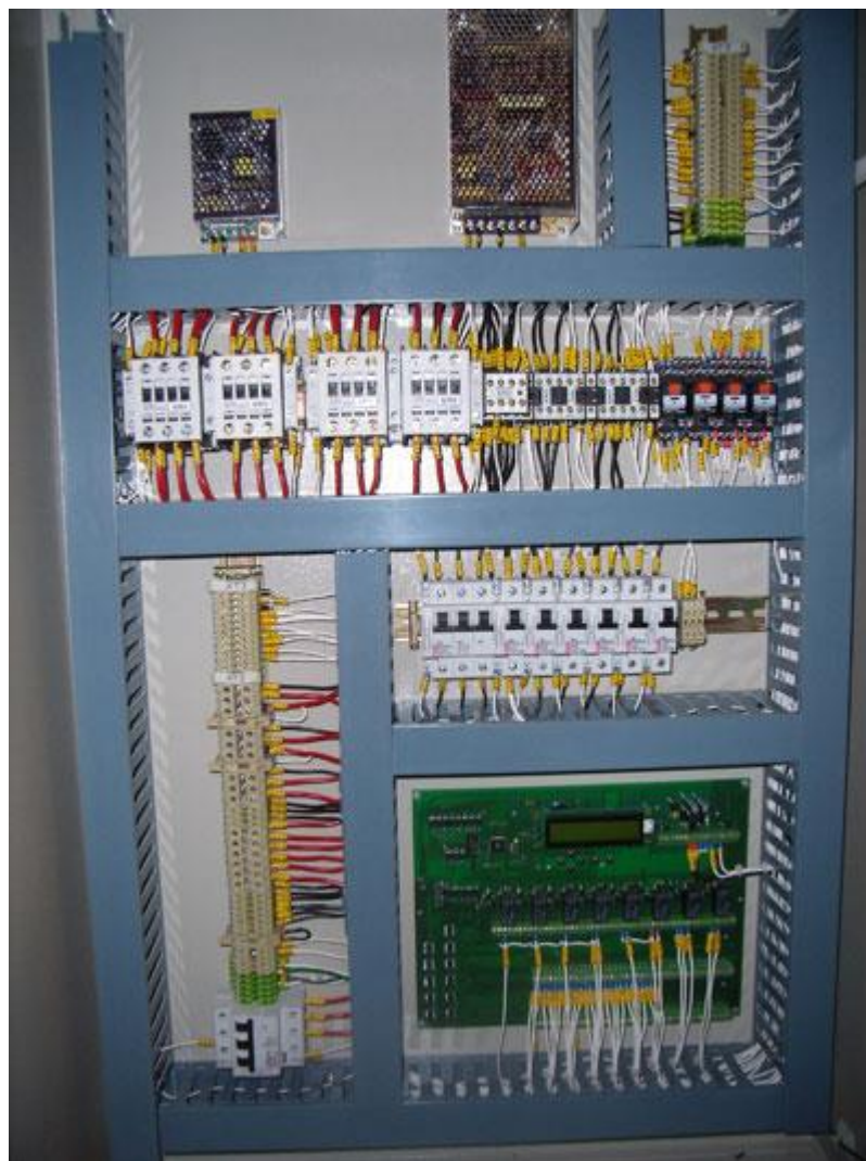
Рисунок 9 – Внешний вид станции
