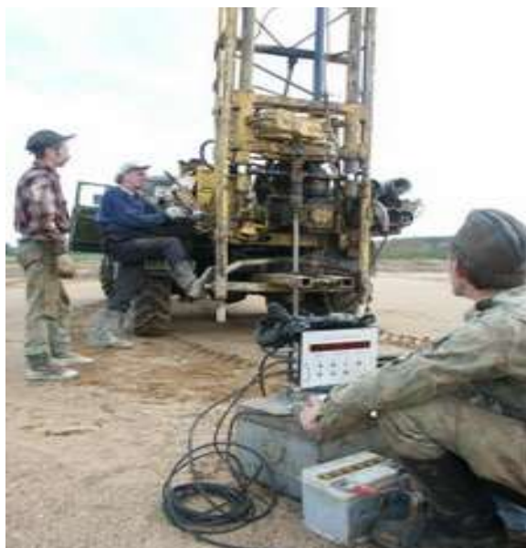
Рисунок 3.4.3 - Установка статического зондирования
