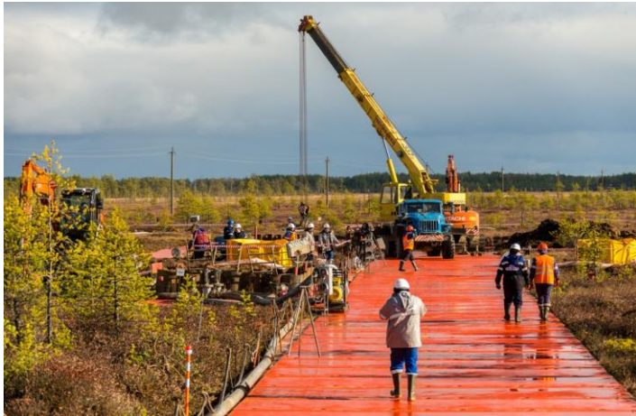
Рисунок 10 – Организация ремонтных площадок
