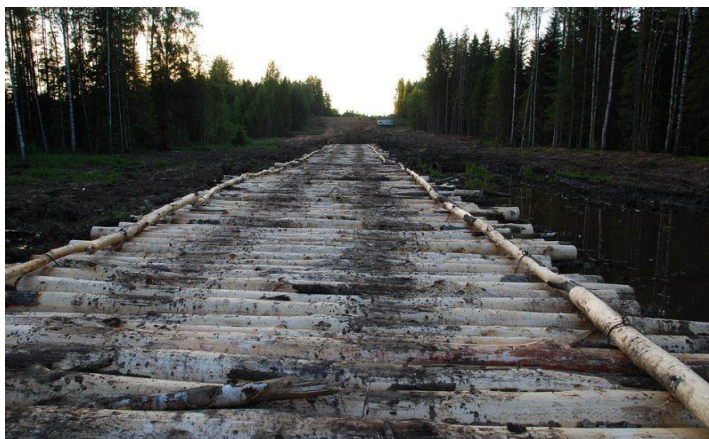
Рисунок 12– Устройства лежневки для ремонтных работ
