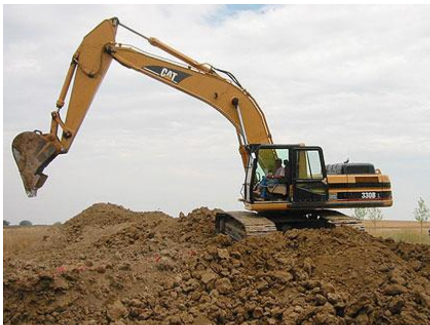
Рис. 6 Процесс разработки траншеи одноковшовым экскаватором
