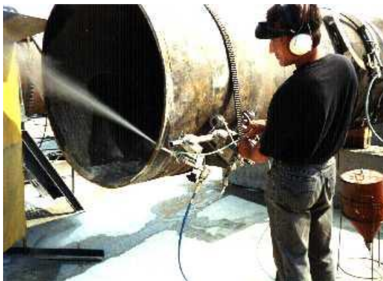
Рис. 28 Ремонт дефекта с вырезом катушки
