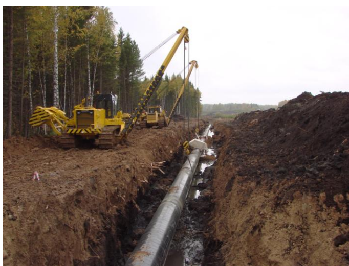
Рис. 1 Капитальный ремонт трубопровода с заменой трубы
