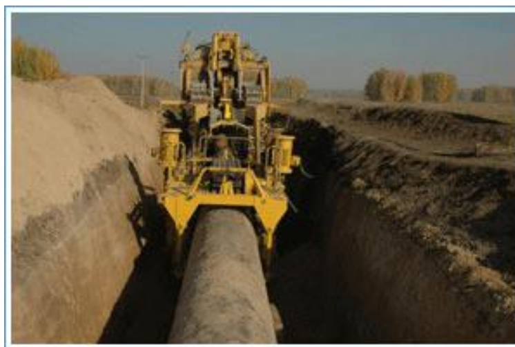
Рис. 8. Подкапывающая роторная машина МПР (МПР-1)
