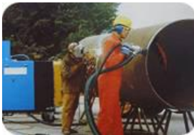
Рис. 14 Очистка наружной поверхности трубопровода
