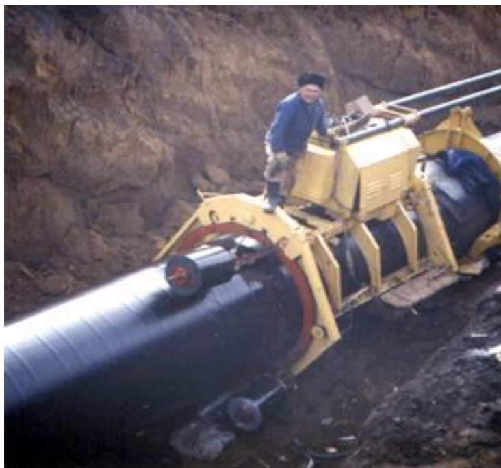
Рис. 2 Капитальный ремонт трубопровода с заменой изоляции
