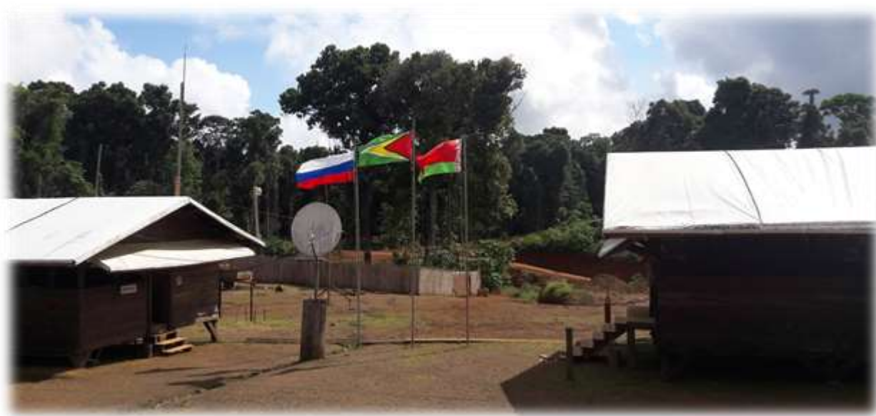
Рисунок 6.7 – Построенные временные здания
