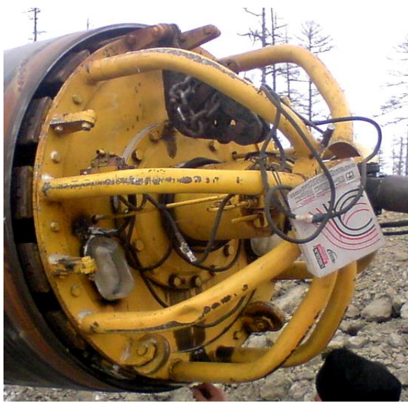
Рисунок 10 – Установка внутреннего гидравлического центратора ЦВ-144 в трубе.
