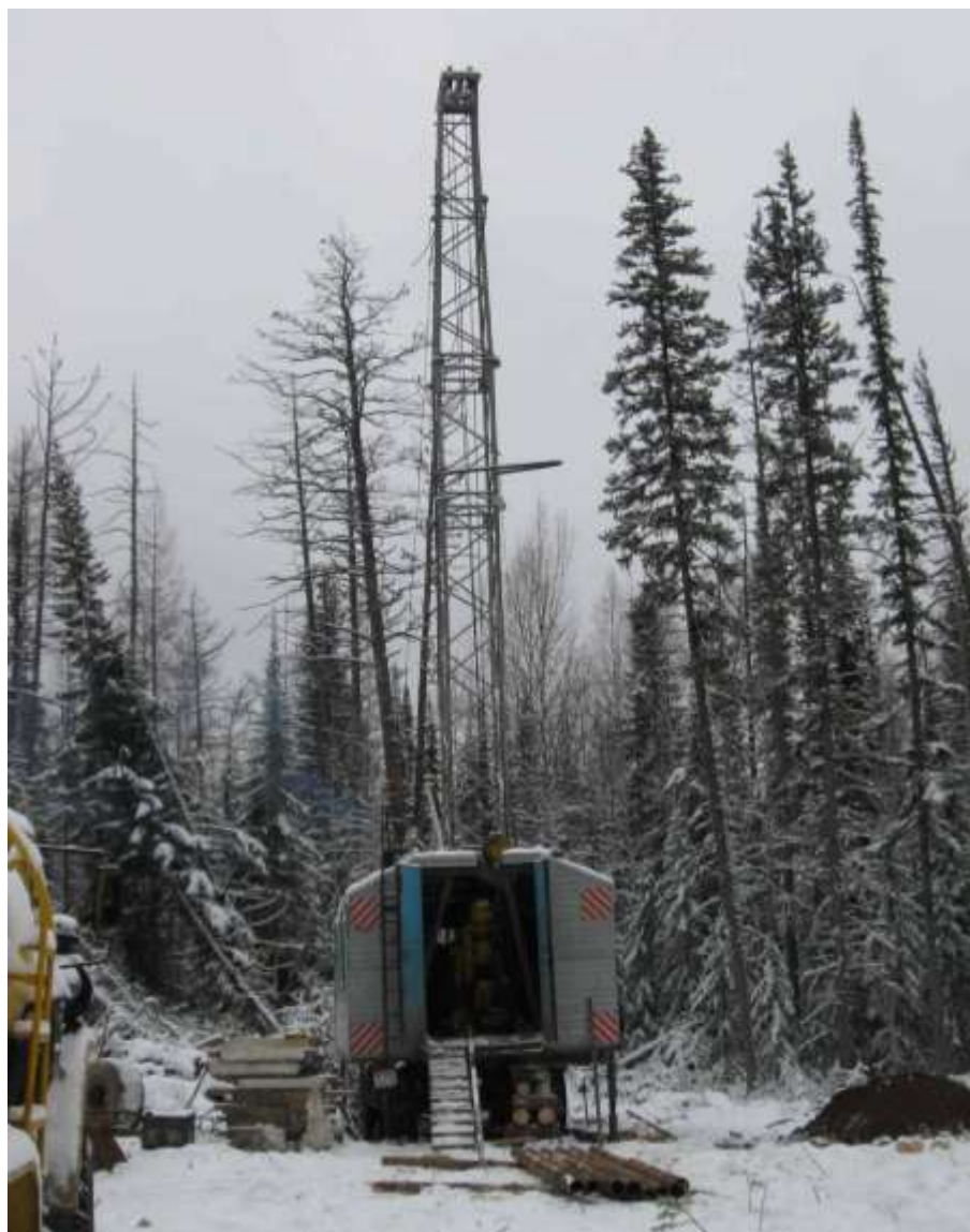
Рисунок 11 – Буровая установка на скважине № 1-3 (04.11.2012 г.)
