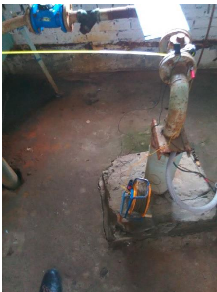
Рисунок 2.2.3 – Обустройство устьевой части скважины № 4П-02
