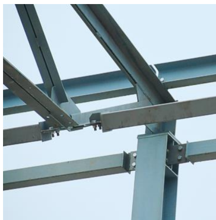
Рисунок 28 Дополнительные связи по нижнему поясу металлоконструкций перекрытия. Все связевые элементы крепятся через двойное болтовое соединение.
