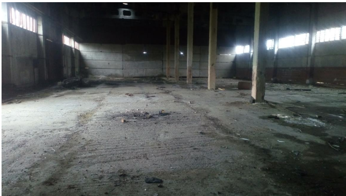
Рисунок 7. Помещение №1 (вид изнутри)
