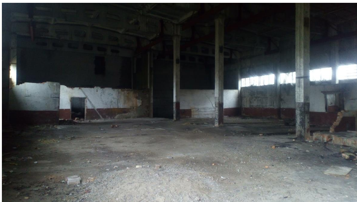
Рисунок 8. Помещение №2 (вид изнутри)
