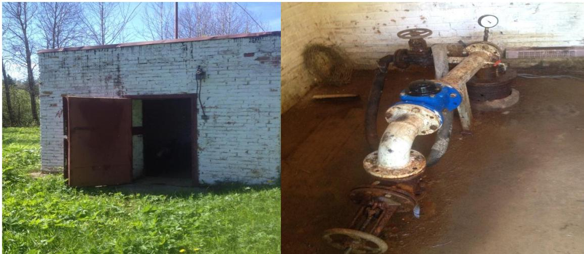
Рисунок 4 – Кирпичный павильон, скважина № 11-127/2 и обустройство устьевой части
