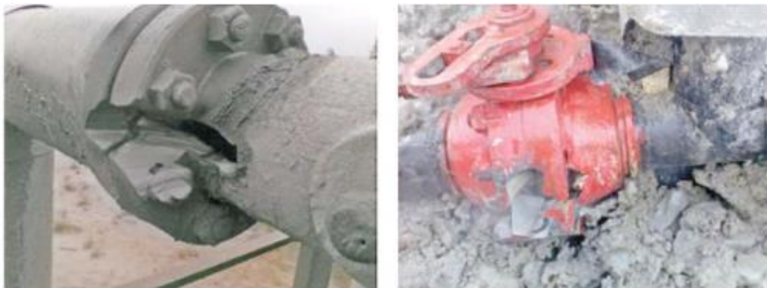
Рис. 1 Разрушение обвязки скважины в результате абразивного износа
