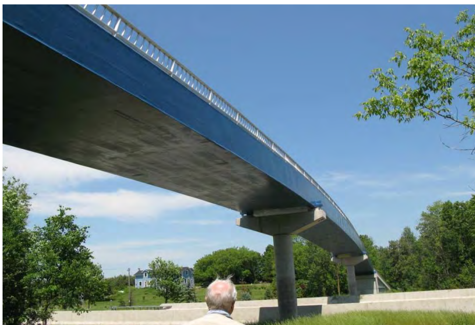
Рис. 1. Мост в Каледоне (Канада).
