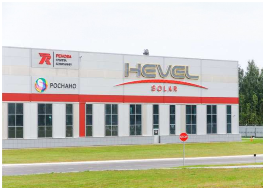
Рис.3 Завод по производству тонкопленочных фотоэлектрических панелей «Хевел», производственной мощностью 130МВт в год
