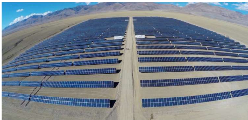
Рис. 5. Фотоэлектрическая станция Кош-Агач (республика Алтай)
