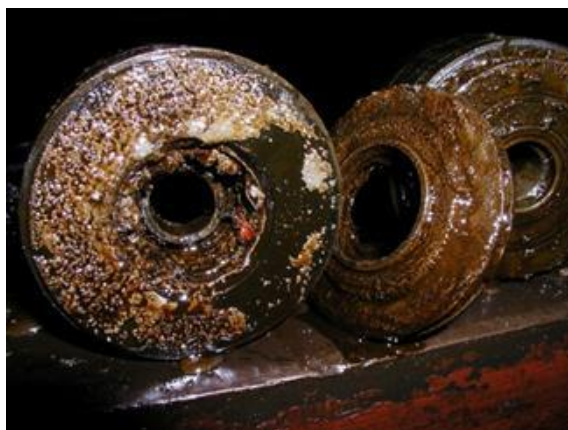
Рисунок 2.4 – Коррозионное воздействие на рабочее колесо
