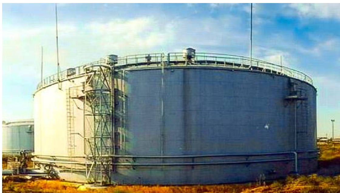
Рисунок 3.3.5 – Шахтная лестница РВС
