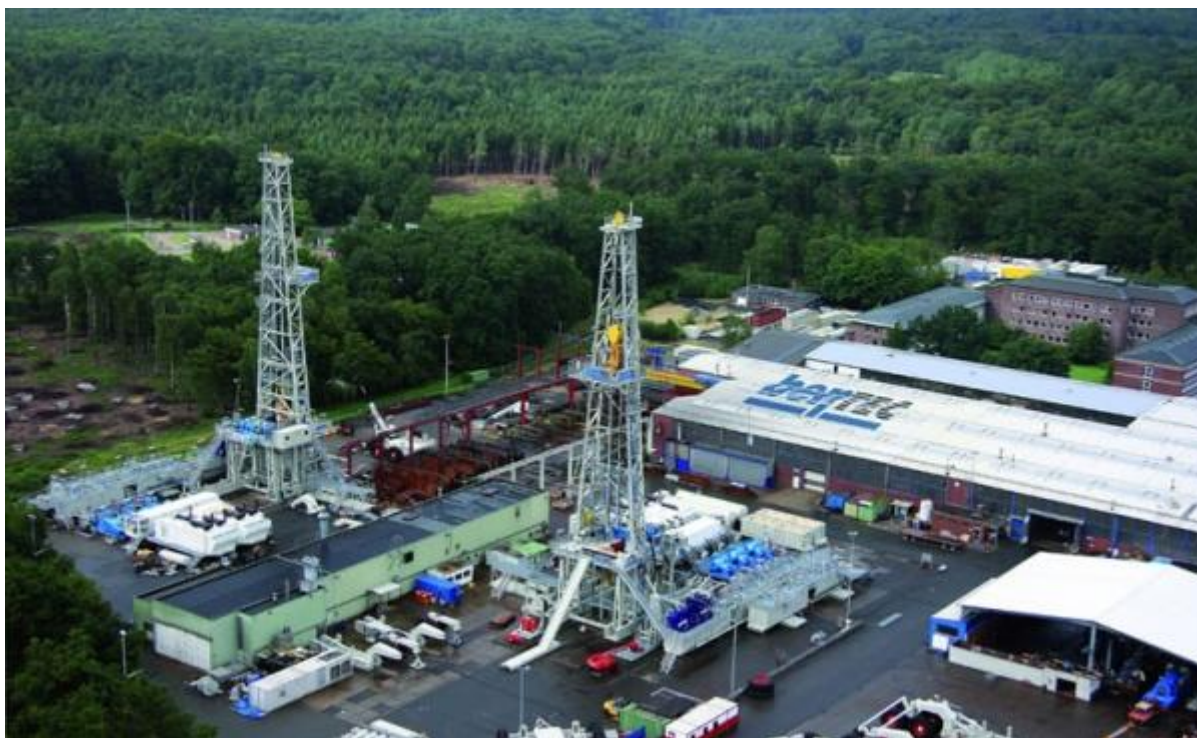
Рисунок 5 – Изготовление МБУ на заводе Бентек
