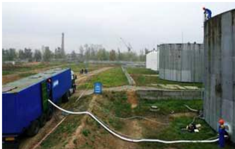
Рисунок 15 – Подача мобильного комплекса к резервуару
