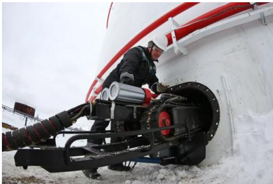
Рисунок 11 – Механический метод зачистки резервуара
