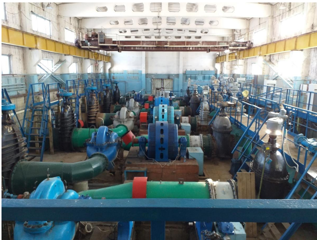
Рисунок 3 – Оборудование для перекачки сточных вод НКС-2
