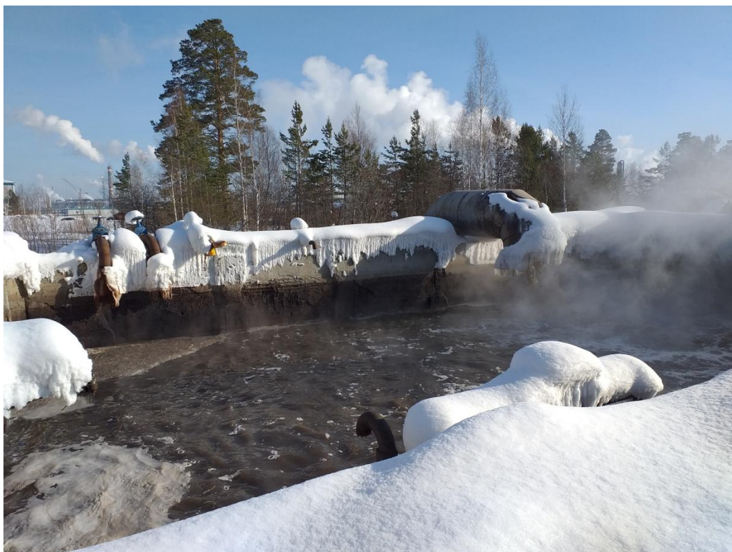
Рисунок 1 – Открытый приемный резервуар сточных вод НКС-2
