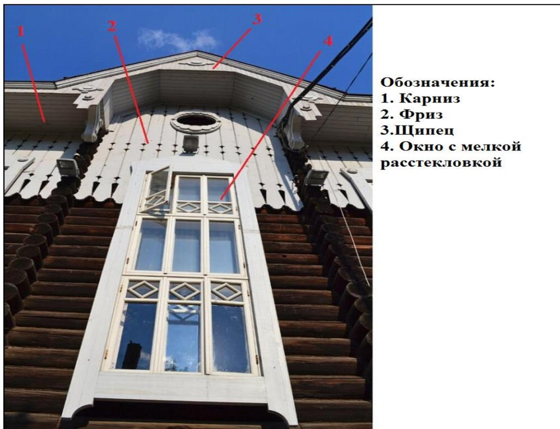
Рисунок 1.5 – Расположение декоративных элементов на центральной части фасада
