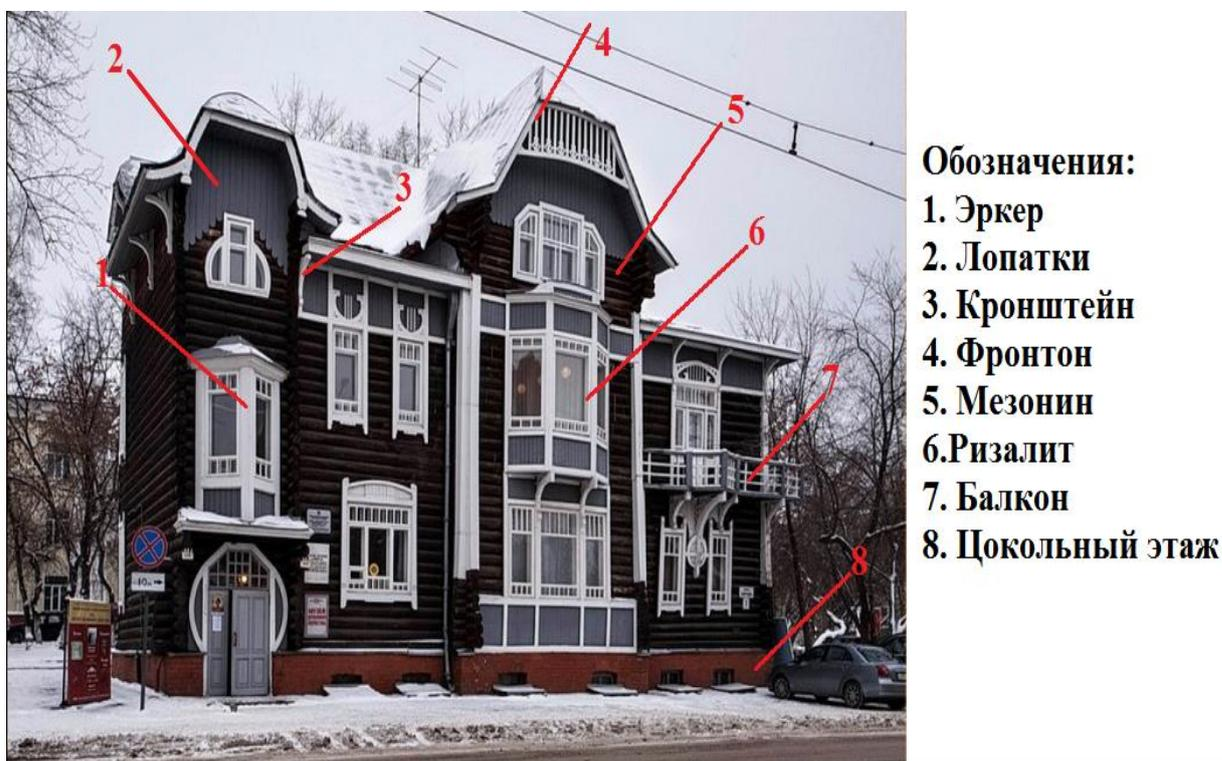
Рисунок 1.6 – Расположение архитектурных элементов на центральном фасаде
