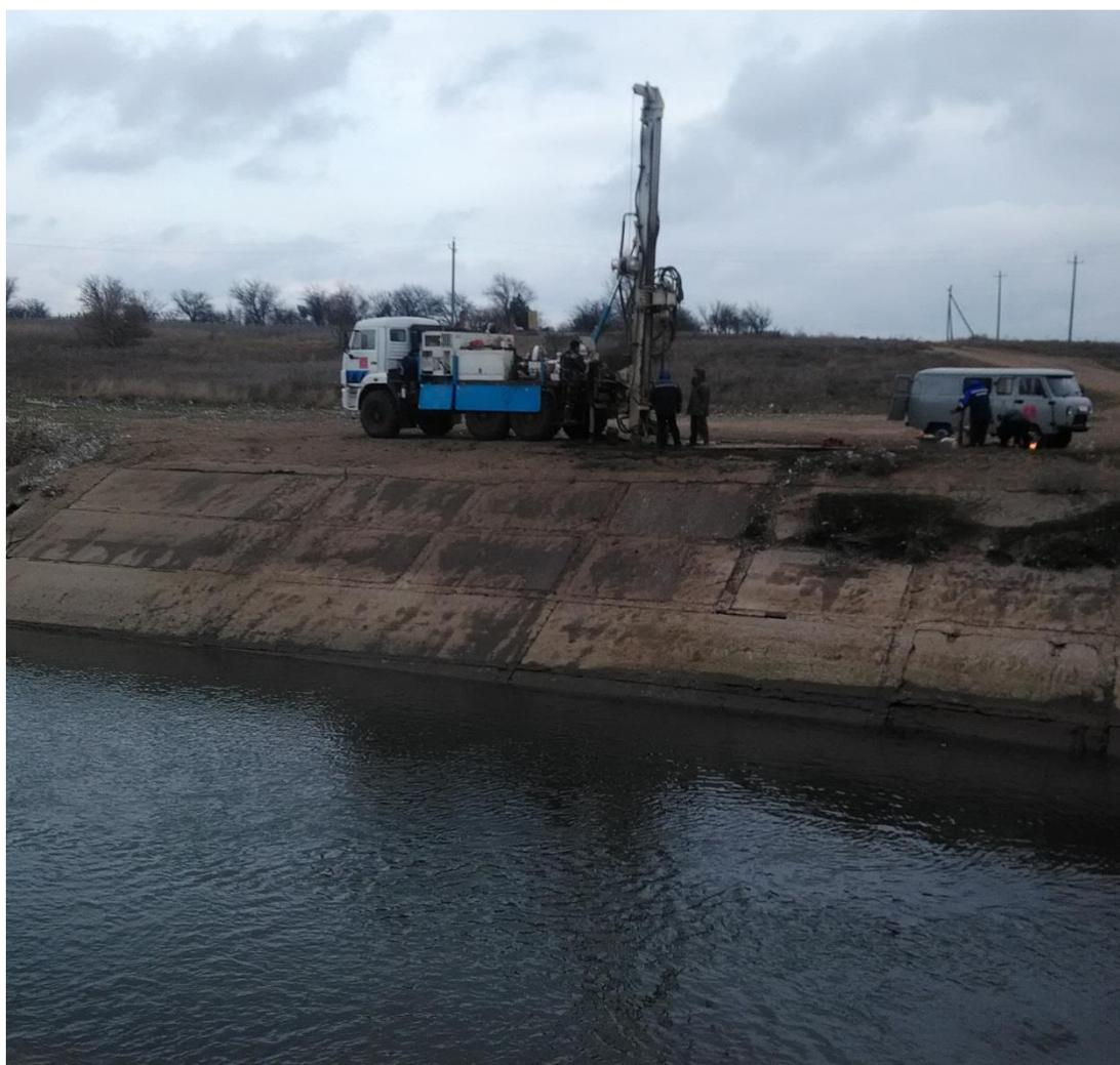
Рисунок 3.3.3.1 Буровая установка УРБ-2А2
