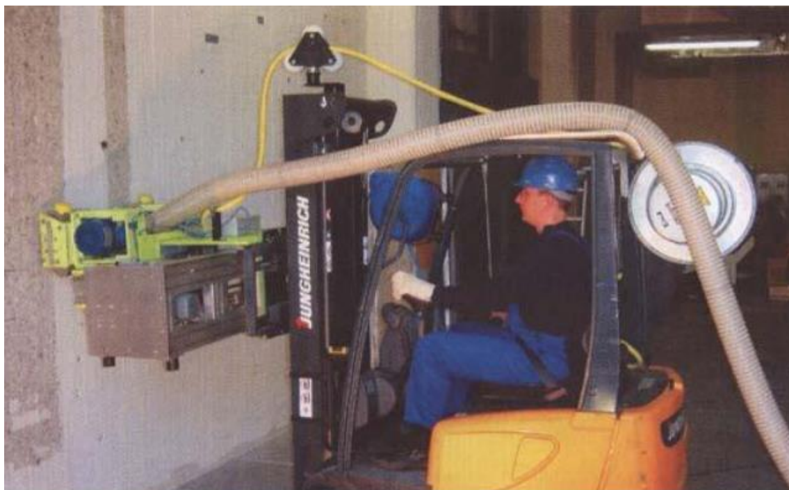
Рисунок 4 – Снятие поверхностного слоя с помощью резцов [17]
