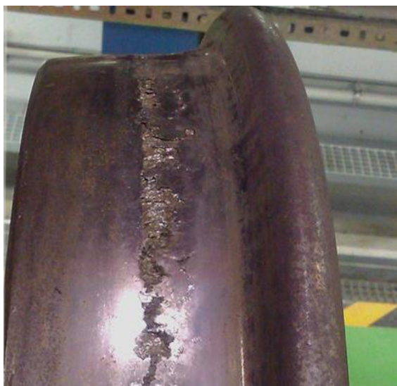
Рисунок 3.1 Дефекты колеса мостового крана
