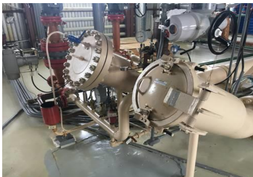
Рисунок 1.4 – Трубопоршневая поверочная установка
