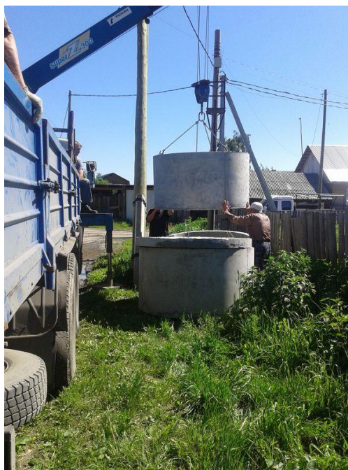
Рисунок 2— «Реконструкция канализации» по адресу с. Дзержинское ул. Волынова, 2
