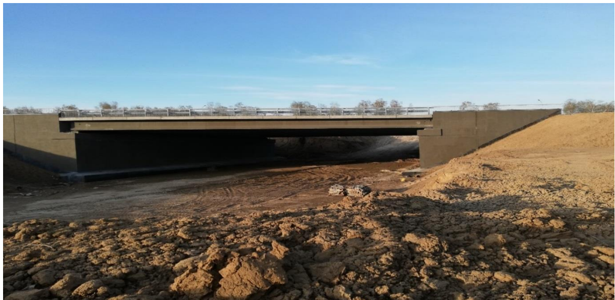
Рисунок 5б – Фактическое состояние двухуровневой развязки на 76 км железной дороги Томск-Тайга (фото от 30.04.2019)
