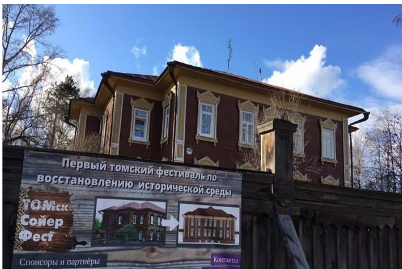
Рисунок 11 - реставрация дома на Дзержинского 17
