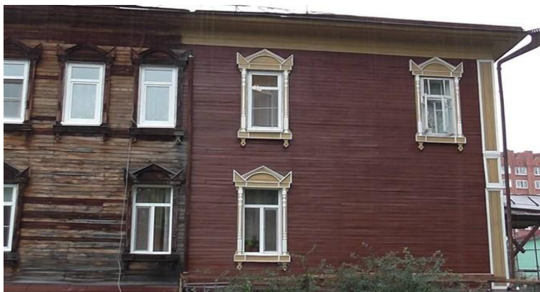
Рисунок 13 - Дом на Дзержинского, 17 в середине работ по покраске фасада
