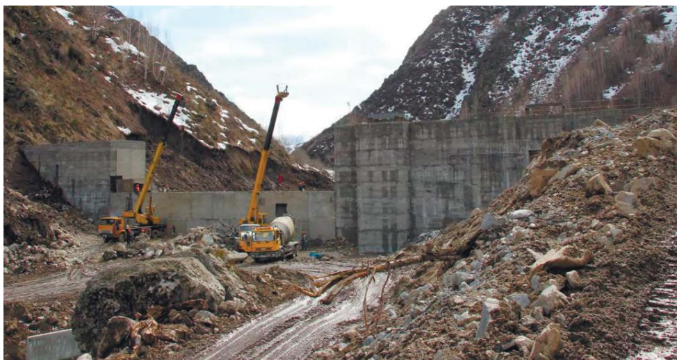
Рисунок 8 – Плотина ГЭС на р. Кора в период строительства
