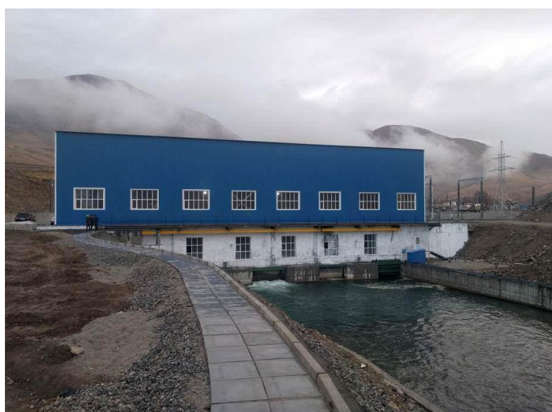
Рисунок 6 – Здание станции № 1 ГЭС на р. Кора
