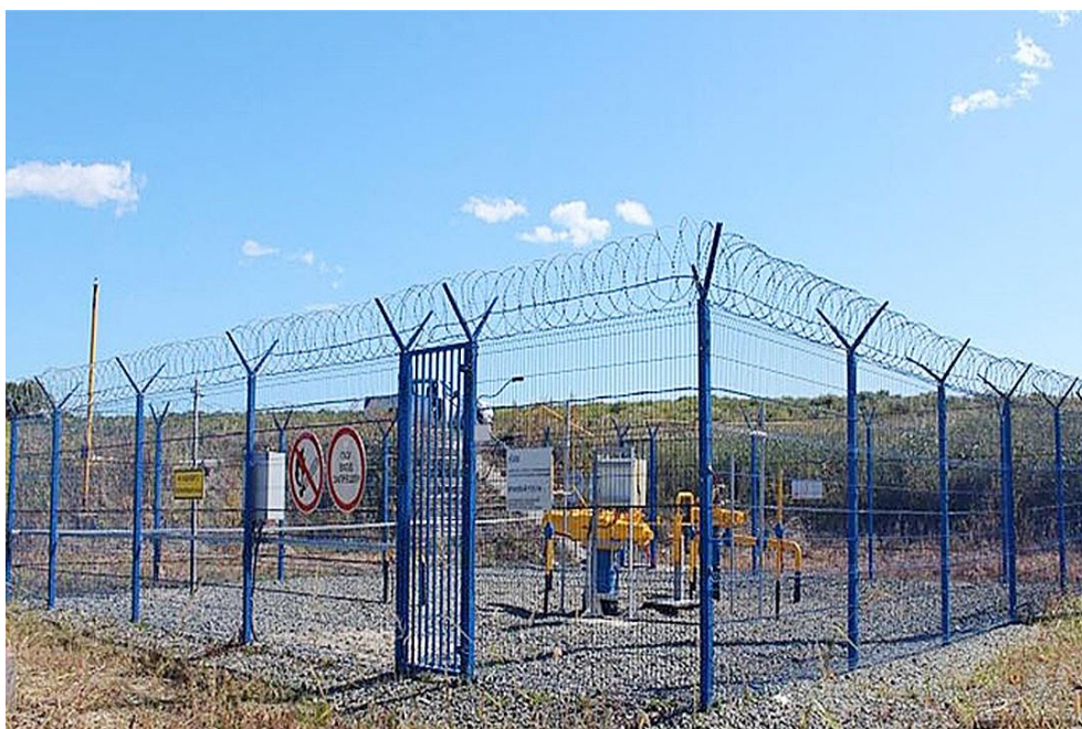
Рисунок 2 – Крановый узел на магистральном газопроводе
