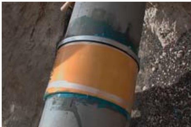
Рисунок 5.5 Завершающий этап установки ремонтной манжеты (ClockSpring) [9]
