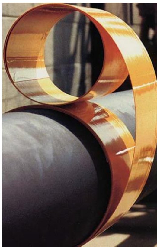
Рисунок 5.4 Установка ремонтной манжеты методом бандажирования (ClockSpring) [9]
