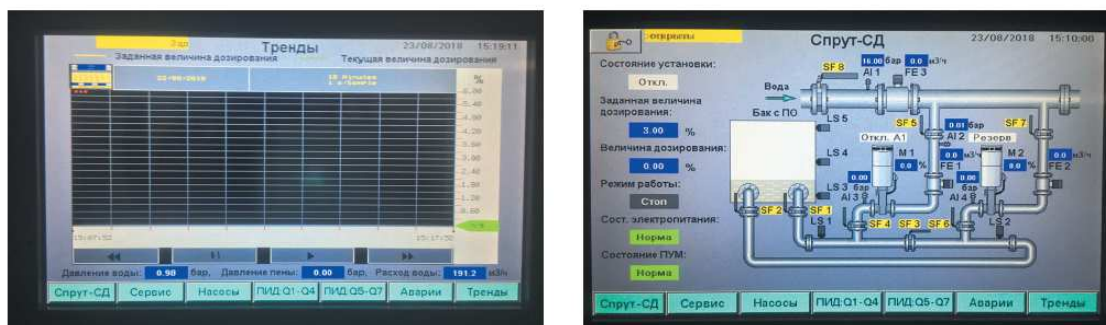
Рис. 2. Общий вид дисплея системы электронного дозирования «Спрут-СД»
