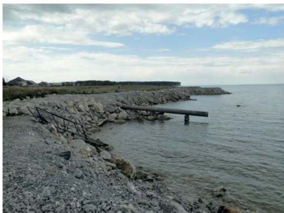
Рис. 5. Примеры берегоукрепления Новосибирского водохранилища
