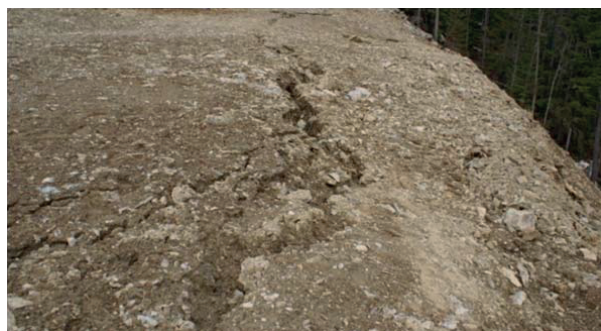
Рис. 9. Трещины оседания
