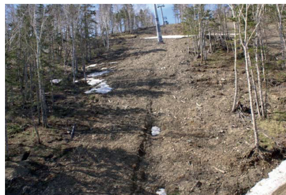
Рис. 11. Просадки грунта в кабельной канаве
