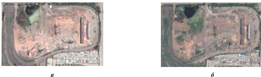
Рис. 2 Изображение снегоотвала расположенного по адресу ул. Мостовая д. 40а в летний период 2017 года (а), 2018 года (б)
