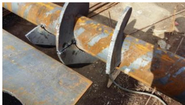
Рис. 3 – Дефекты шнека – разрывы
